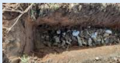
Réalisation d'un talus filtrant à Plouvorn
