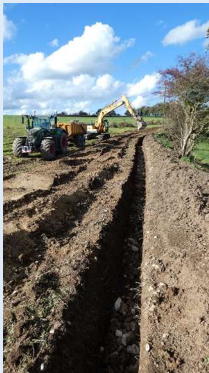
Réalisation d'un talus filtrant à Plouvorn
